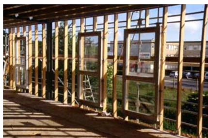
La carcasse métallique réalisée, les corps d'état secondaire interviennent pour réaliser les remplissages.
