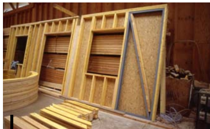
Intégration de cadres métalliques dans les panneaux pour répondre aux contraintes sismiques.
