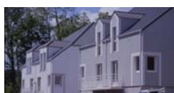
49 logements à Evreux (Eure)
