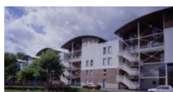
51 logements à Evreux (Eure)
